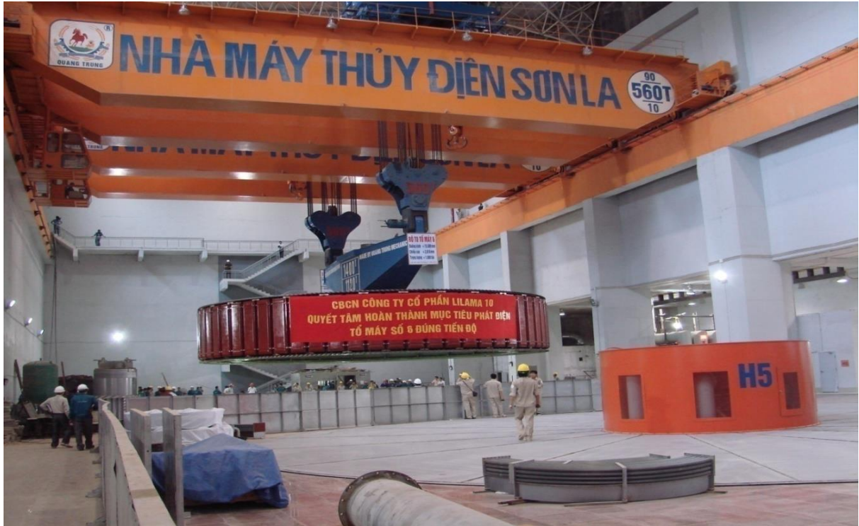
THỦY ĐIỆN SƠN LA (Hạ Rotor Tổ máy thứ 6)
